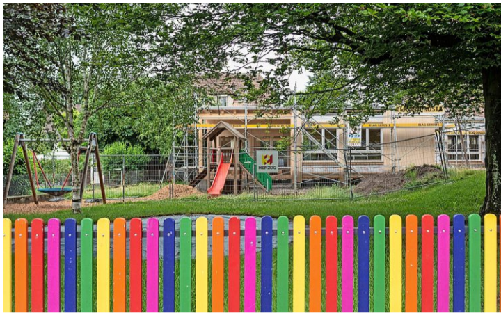
Die Bauarbeiten am Kindergarten am Reinhardweg kommen planmässig voran. Foto: Franziska Rothenbühler
